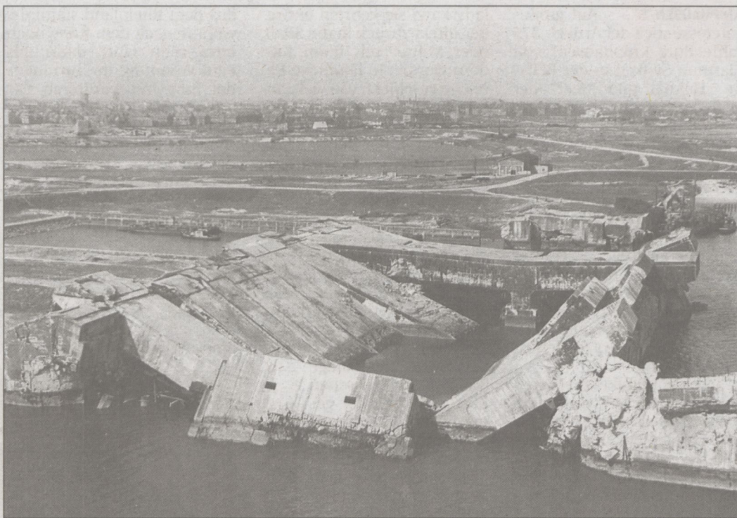
Die Alliierten ließen die Torkammern und Schleusenhäupter sprengen, eine völlige Zerstörung der Schleuse kam wegen des Hochwasserschutzes nicht infrage. FOTO: STADTARCHIV
